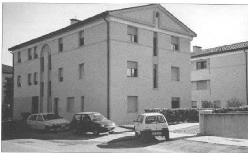
Zerman di Mogliano: lavori di manutenzione straordinaria in via della Chiesa
